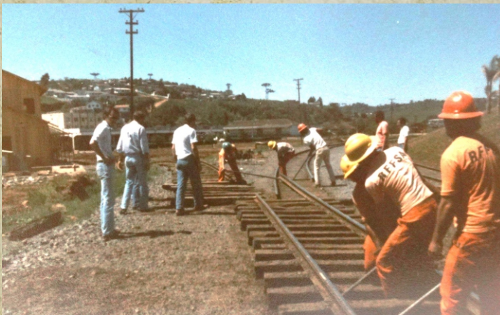
Obra desvio dos trilhos para colocar máquina e vagão no Museu do Contestado de Caçador.
